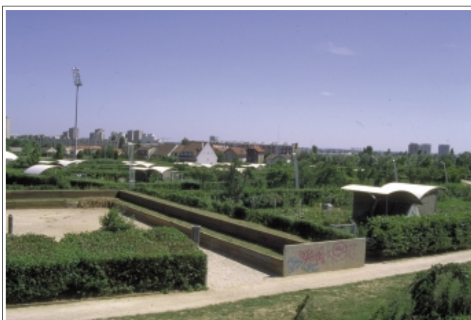
ECB-LFCTF - Architecture pour abris de Jardins Familiaux à Villejuif (Ile de France) dans le parc départemental «des Hautes Bruyères» (Renzo Piano, architecte)
